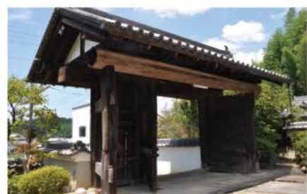
9 子嶋寺(こじまでら) 真言宗高野派。室町期に衰退しましたが高取城主の庇護を受け今日に至ります。山門は高取城二ノ門の移築で、貴重な高取城現存遺構です。
