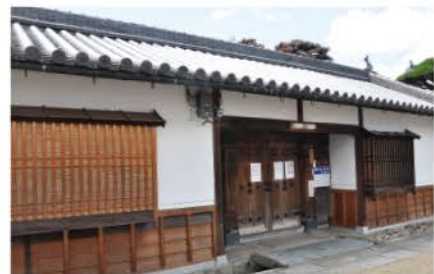
7 石川医院 かつての藩主下屋敷の表門が、石川医院に移築されて現存しています。
