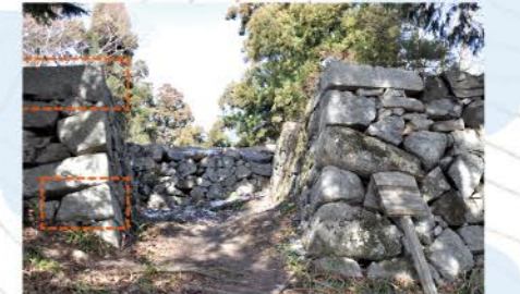
①天守台穴蔵(あなくら)入口の転用石 高取城の石材には古墳の石棺が使用されています。どこにあるか転用石を探してみてください。
