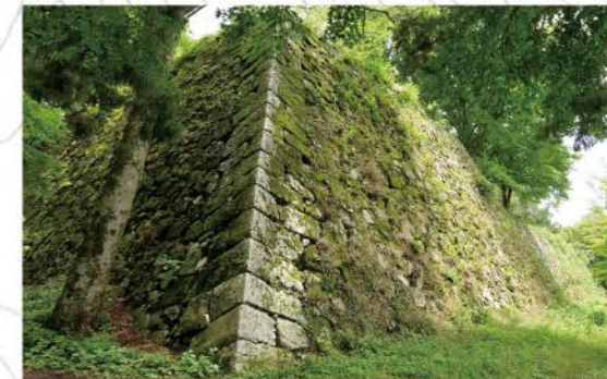
①本丸天守台の石垣 城内最大の高さ(約12m)を誇る圧倒的な天守台石垣。かつて三層の天守が建っていました。現在の趣ある苔むす石垣の姿も魅力があります。
