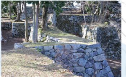
②本丸虎口の石垣 城の出入口を虎口(こぐち)と呼びますが、最も厳重な形式が樹形虎口(ますがたこぐち)です。本丸の樹形虎口は城内でも特に強固です。
