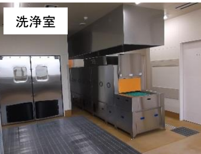
スプーン、食器、トレー、食缶を洗浄機で効率よく衛生的に洗浄します
